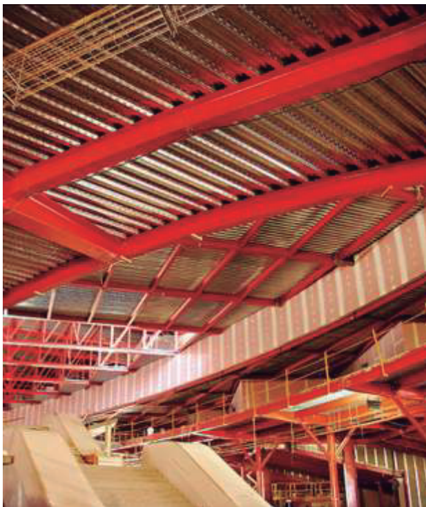
Solución acústica compuesta por chapa metálica perforada, y panel de doble densidad.
